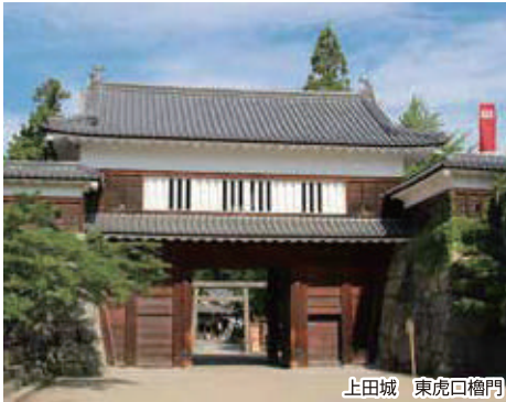
上田城 東虎口櫓門
