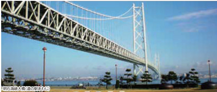
明石海峡大橋(道の駅あわじ)
